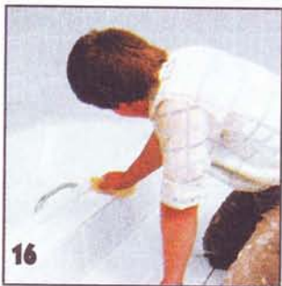
16 Излишки раствора удаляют влажной губкой.
