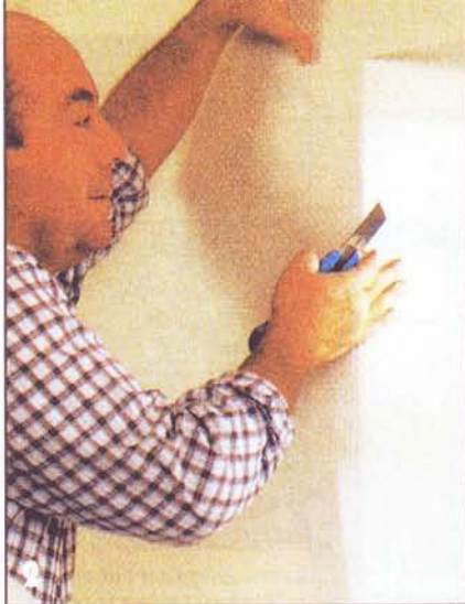
Участок стены поверх окна оклеивают одним куском обоев. Приложенное к стене полотнище обоев натягивают и тщательно разглаживают.
