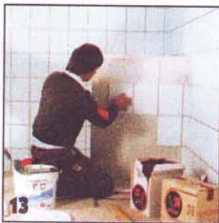
13 Плитку крепят на клей, нанесённом на основу тонким слоем.
