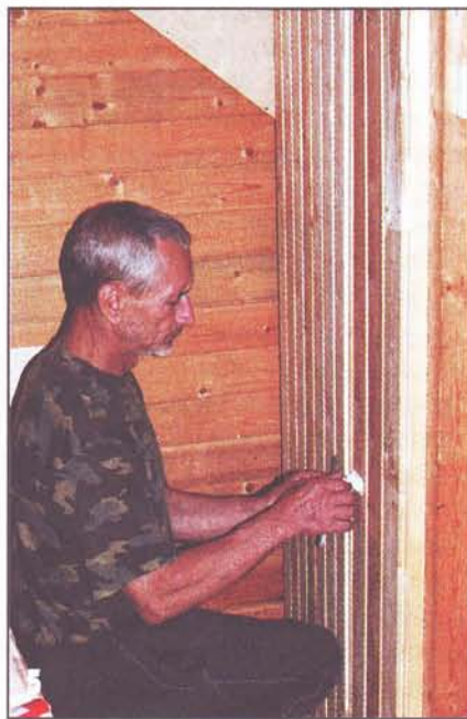
Теперь надо приладить запор, дополнить неподвижную часть ограждения составным плинтусом и закрыть проём в подлестничное пространство.
