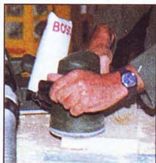
Переходы между отдельными участками зачищают шлифовальной машинкой.
