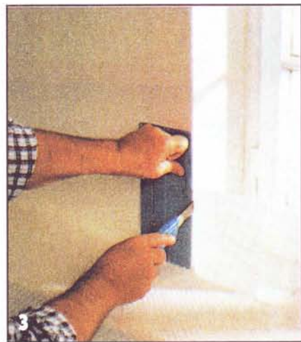
Оклеивают обоями также подоконник и выступ стены. Обрезают обои по шпателью.
