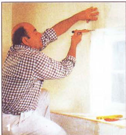
Загрунтовав стены, наносят на них клей и оклеивают стеклотканевыми обоями. Лишний нависающий кусок обоев у оконного откоса аккуратно обрезают.
