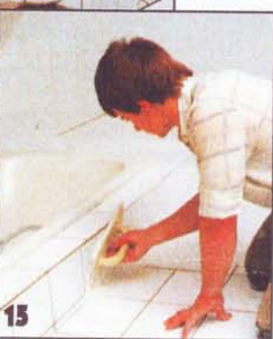
15 Швы между плитками расширяют белой затиркой, которую наносят и разглаживают резиновым шпателем.
