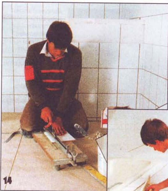
14 Раскраивают плитки с помощью плиткореза.
